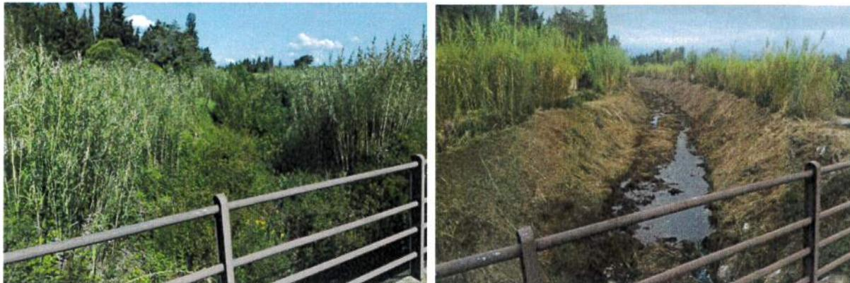
La régie (équipe verte) du SMTBV intervient également ponctuellement sur la restauration de cours d'eau, indépendamment des travaux et de l'entretien du patrimoine hydraulique en propre. Ces travaux (abattage et d'élagage d'arbres, enlèvement d'embâcles et de bois morts, débroussaillage) ont notamment porté sur : la Coumelade à St Féliu d'Amont, le Cady à Vernet-les-Bains, le Fillols à Fillols, la Têt à Fontpédrouse, la Ribérola à Fontpédrouse et le Roumanis à Ponteilla.
