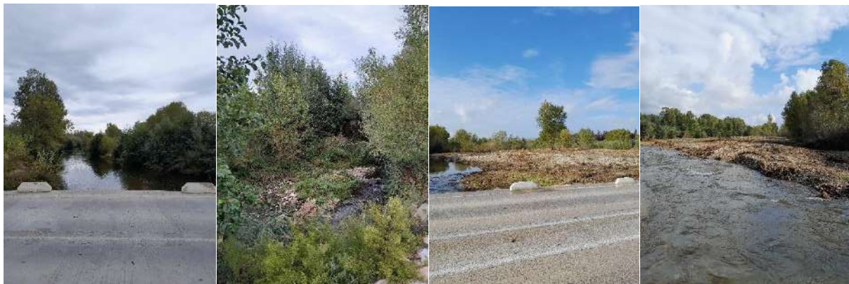
Photographies avant – après travaux au niveau du passage à gué de Bompas
