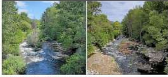
Vue de la Têt depuis le pont de Prades avant et après les travaux.
