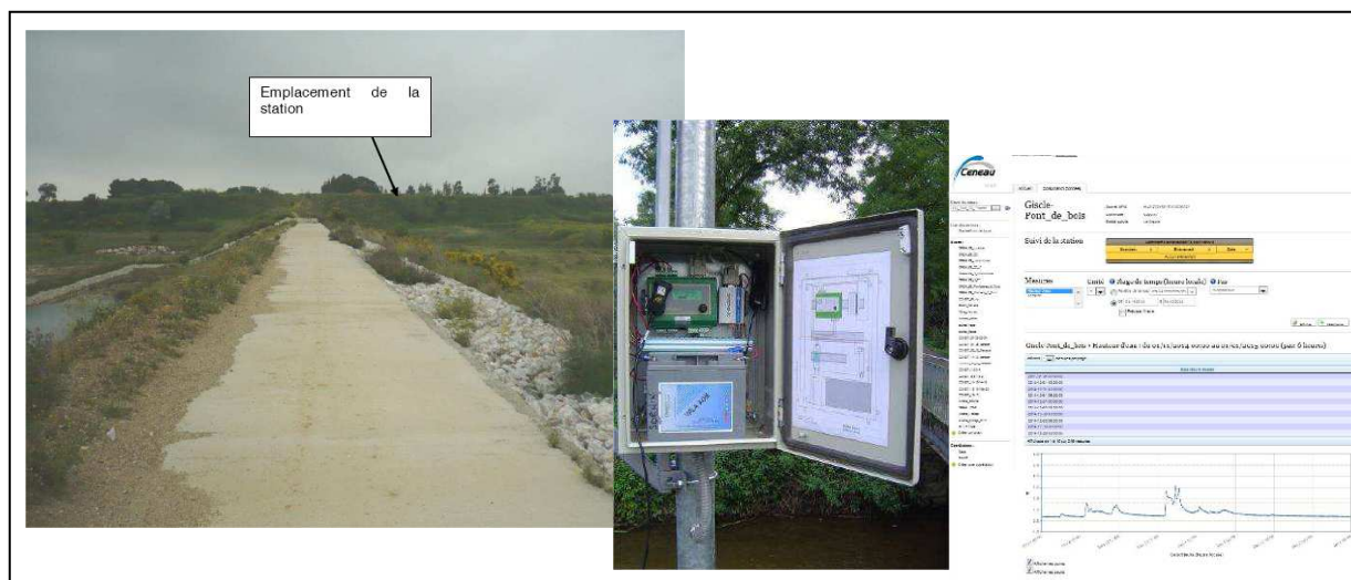
Figure 10 : dispositifs de surveillance des barrages de la Courragade
