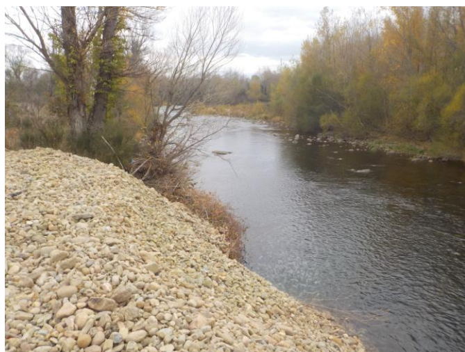
Réinjection sédimentaire à l'aval du seuil de la Reglella – CD66
