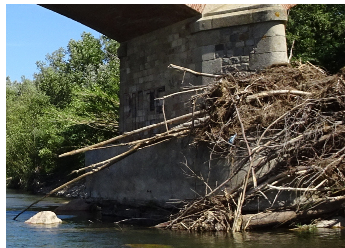
Déchaussement pile de pont de Millas
