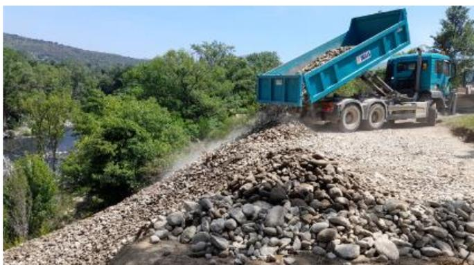
Figure 3-32. Photographie illustrant une réinjection des matériaux en aval du barrage de Vinça.
