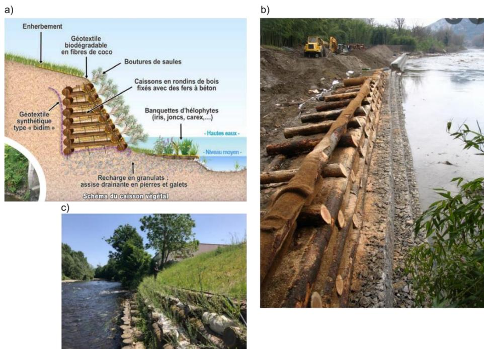
Figure 3-15. (a) Schéma détaillant la structure composant un caisson végétalisé et (b et c) des photographies illustrant la mise en place de ces caissons sur différents cours d'eau.
