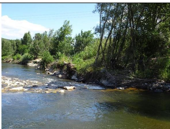
Vue vers l'aval de la rive droite. Affaissement des berges et érosion au droit de la RN116
