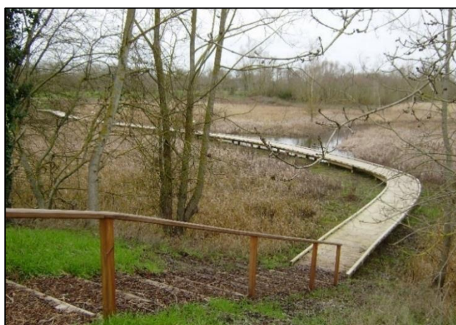
Figure 1 : Mise en place d'un cheminement au sein d'une zone humide (© ECOTONE)
