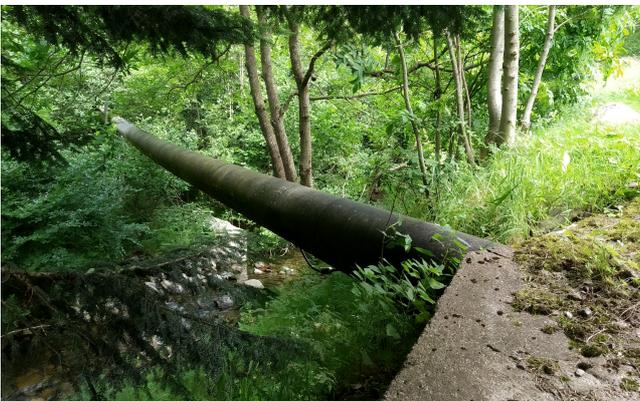
Figure 16 : Conduite forcée de la micro-centrale
