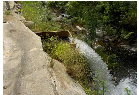
Figure 17 : Retour au Caillan après turbinage
